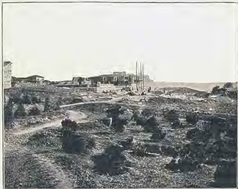
L'ÉCOLE ACTUELLE EN CONSTRUCTION 2
