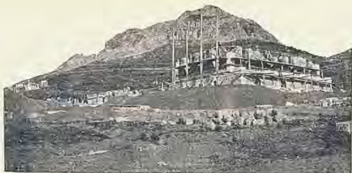
L'ÉCOLE ACTUELLE EN CONSTRUCTION 1
